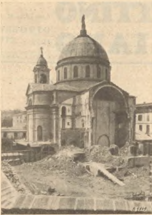
L'abside della Basilica di Maria Ausiliatrice dopo la demolizione del coro e delle sagrestie.
